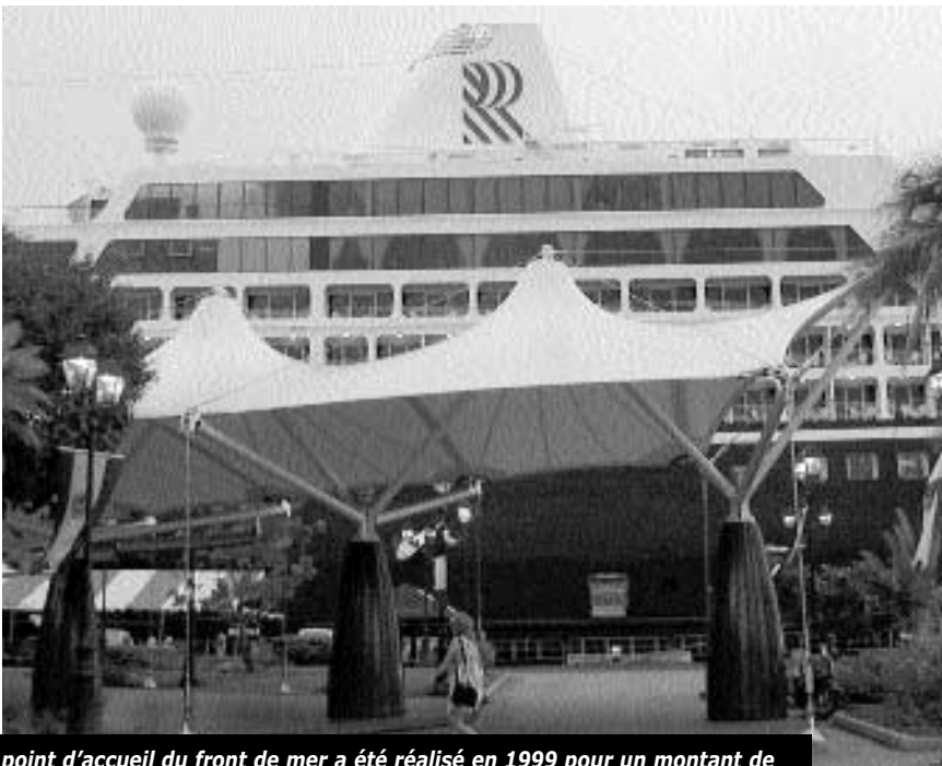
Le point d'accueil du front de mer a été réalisé en 1999 pour un montant de 200 millions FCP (11 millions FF).
