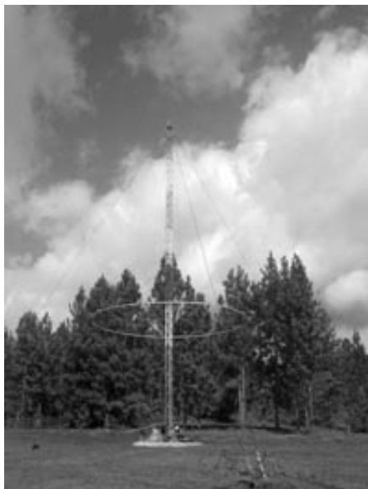
Côté matériels, les télécommunications HF sont surtout spectaculaires par la taille des antennes que nous utilisons : de 12 mètres pour la plus petite aux grandes antennes qui culminent à 32 mètres et pèsent deux tonnes.
