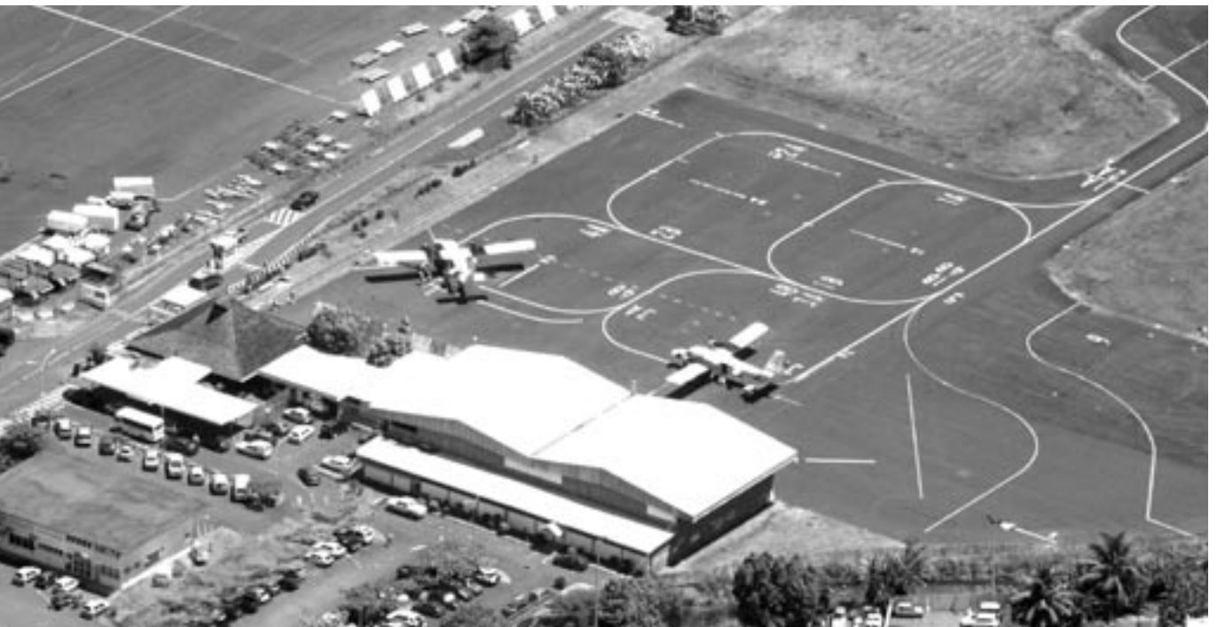
Un hangar d'entretien « provisoire » est en phase de réalisation sur l'aire Golf, actuellement utilisée par Air Moorea.
